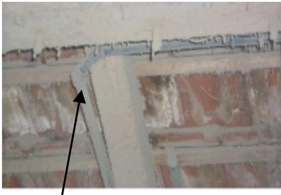
Bild 4 Ansaugrohr im Siloboden
