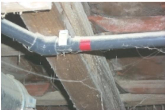
Bild 2 Ansaugrohr mit Staubablagerung
